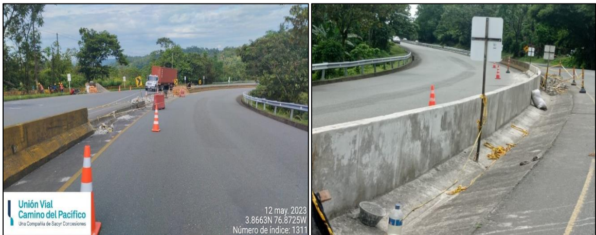
RN 4001 – PR 47+200 – Sello de Fisuras
