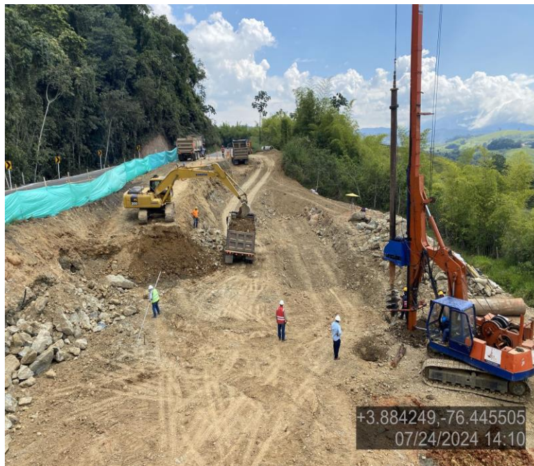
Ilustración 18. Avance de obra
