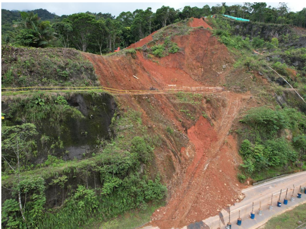
Ilustración 12. Avance de obra
