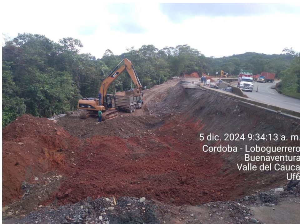
Ilustración 10. Avance de obra
