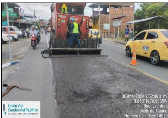
RN 4001 - PR 12+060 Bidireccional – Micropavimento
