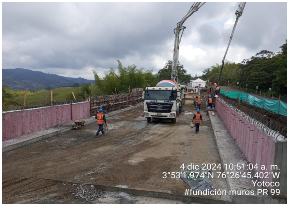
Ilustración 25. Avance General de obra
