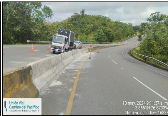
RN 4001 - PR 27+000 Calzada Izquierda – Reposición de Barrera Tipo New Jersey
