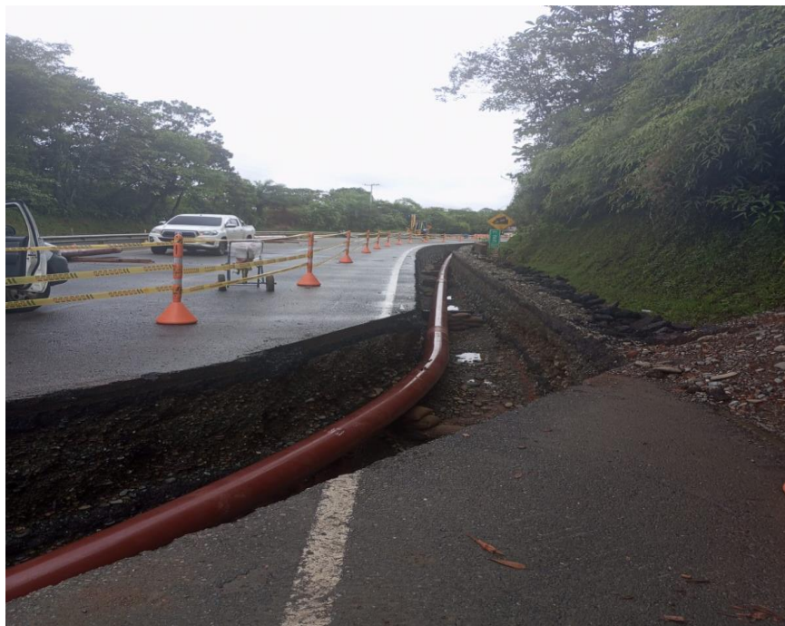
Ilustración 5. Traslado de Poliducto PR25
