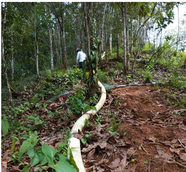
Ilustración 7. reubicación de tubería PR41
