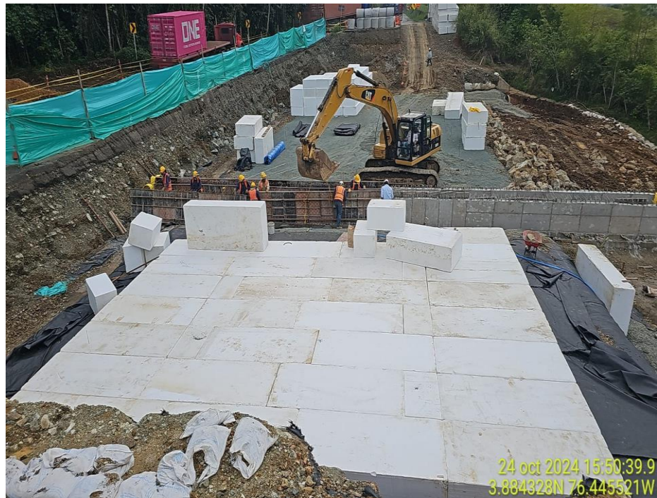
Ilustración 21. Avance de obra
