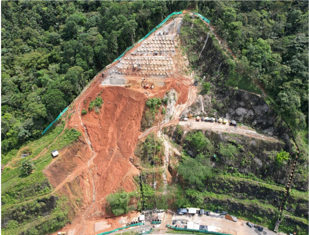
Ilustración 16. Avance de obra
