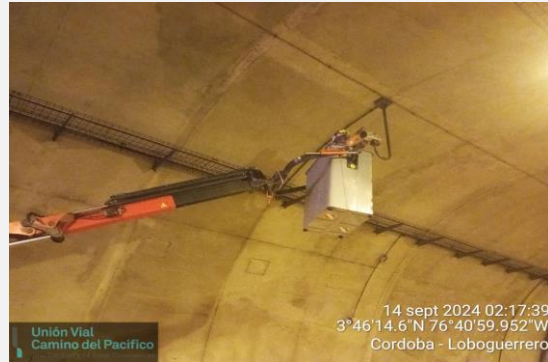
Mantenimiento cámara DAI de túnel
