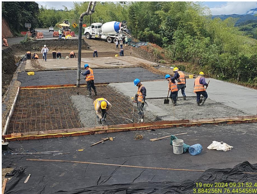
Ilustración 23. Avance de obra
