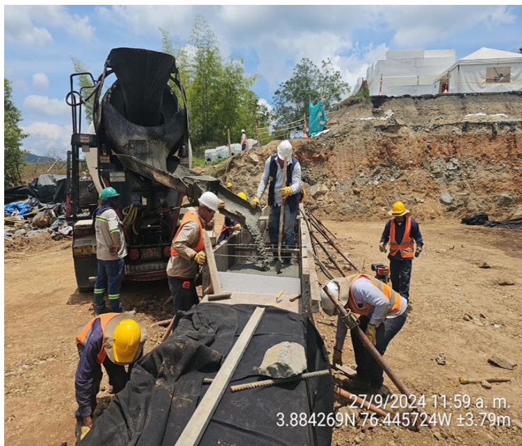
Ilustración 20. Avance de obra
