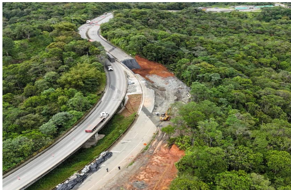
Ilustración 11. Avance de obra
