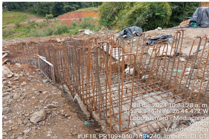
Ilustración 22. Avance de obra
