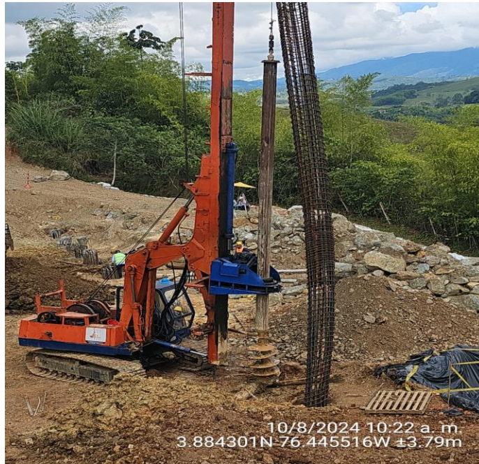
Ilustración 19. Avance de obra
